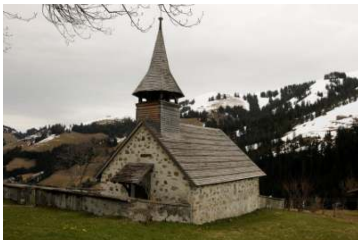
Kirchlein Abländschen, erbaut 1612
